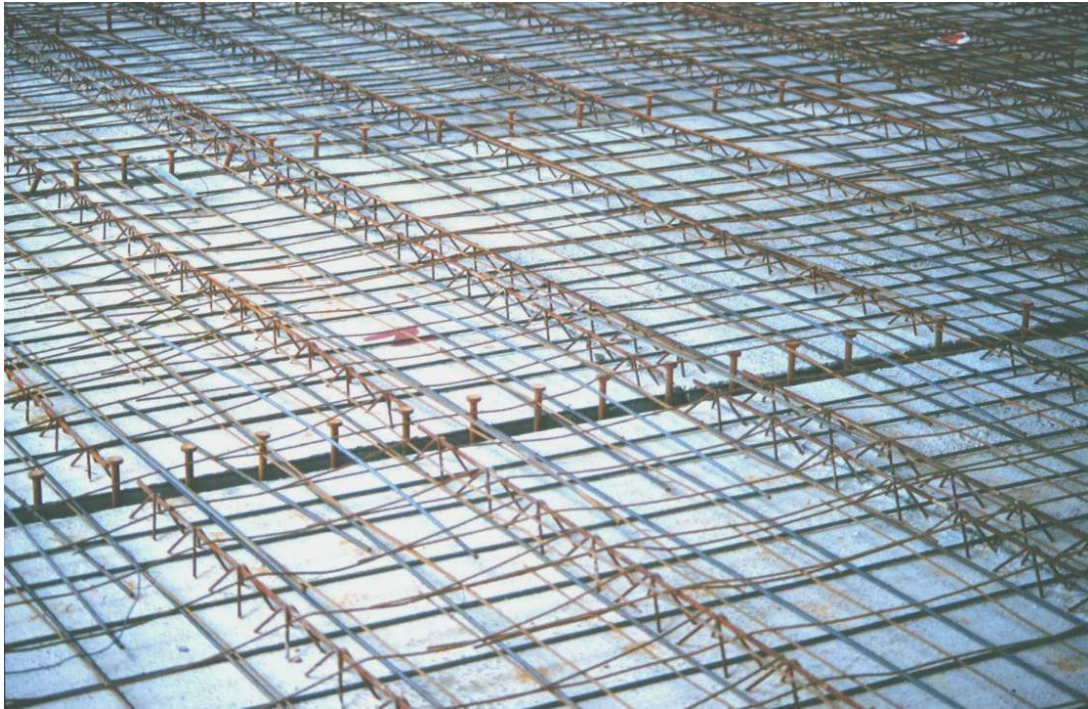
Fig. 1.3: soletta collaborante con lastre Predalle
